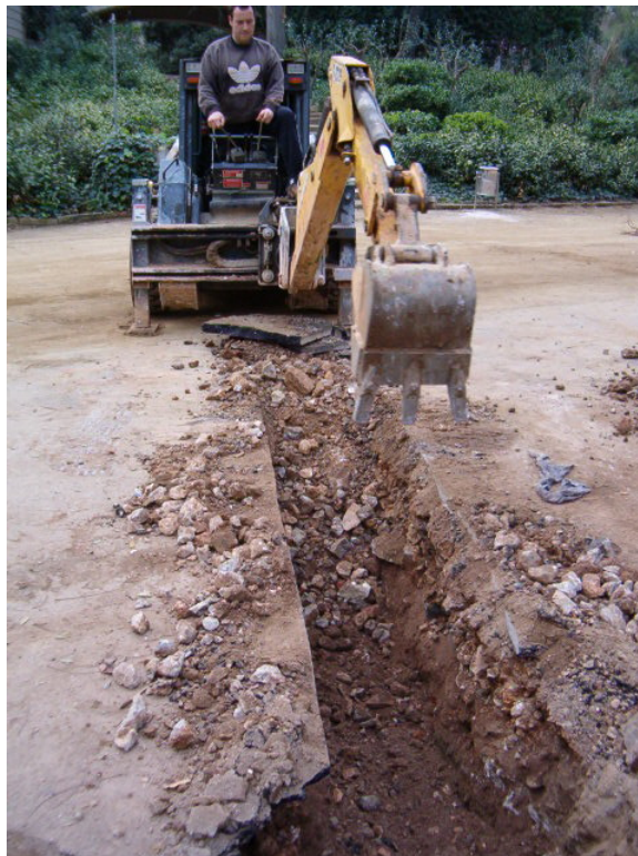
Obertura del sector 2. Vist des de l'est
